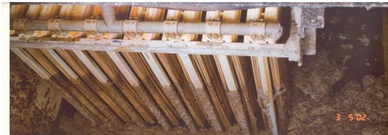
Figura 29 Membranas submersas no tanque de aeração - Zenon®
