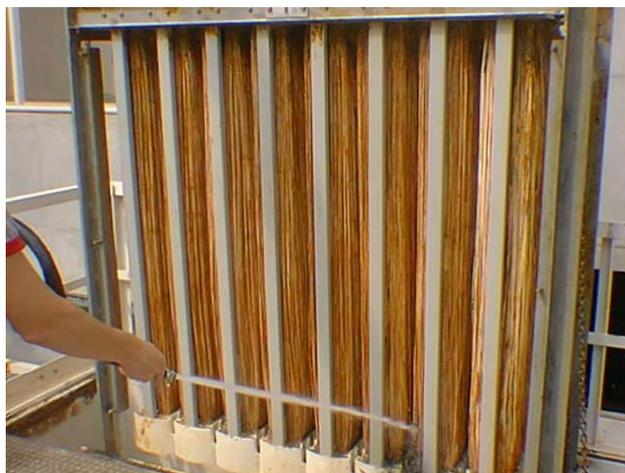
Figura 30 Limpeza de um módulo de membrana submersa MBR - Zenon®
